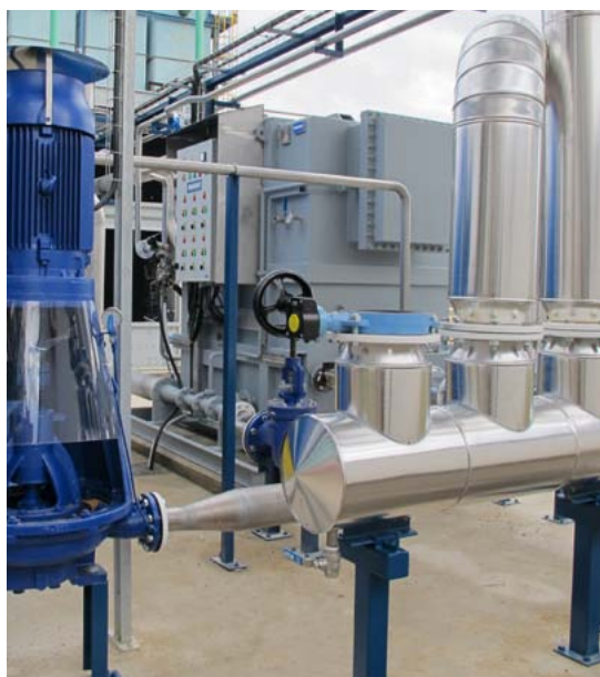
Viscofan. Evaporator AQ-100/120A in CHP plant. Navarra - España.
